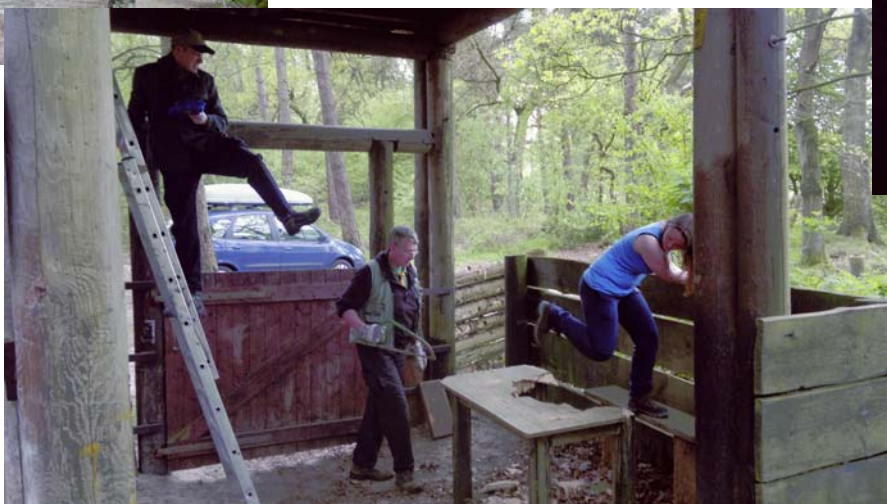
Abriss alter Wachtisch
